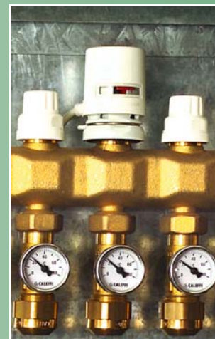
Elektriajamid paigaldatakse valgete tagasivoolu ventiilide kaitsemütside asemele.
