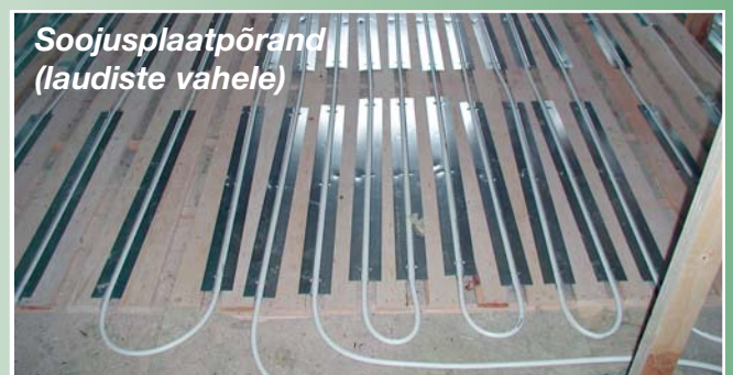
Soojusloovutusplaat põrand (harvlaudise vahele)
